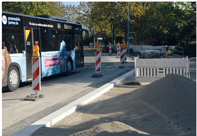
Die Umbauarbeiten an der Haltestelle Habichtweg sind in vollem Gang – Stand 1.10.2023
